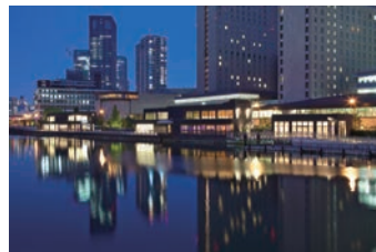
中之島バンク 日本初、河川敷を利用したにぎわい空間が今年5月グランドオープン。開発から参画し、コンセプトプランニング、建築デザイン、各店舗の内装デザインをトータルで手がけた。
